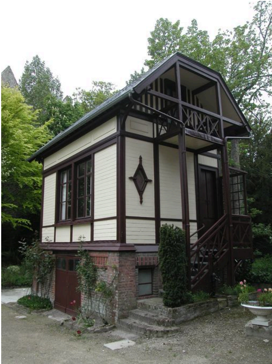
Vue d'ensemble des communs, vers l'entrée.
