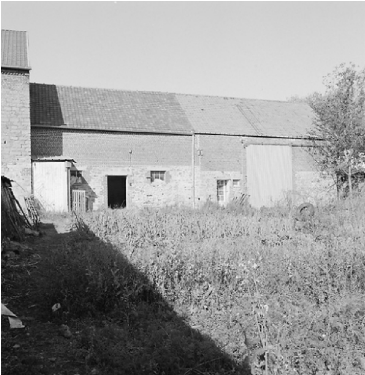
Vue de l'élévation postérieure des étables et de la grange annexe.
