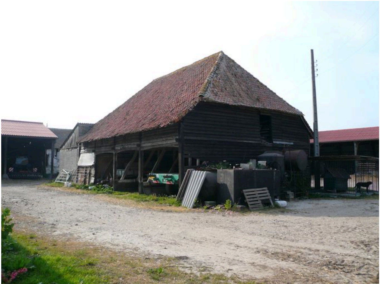
Vue de la charretterie et du grenier sous les combles.
