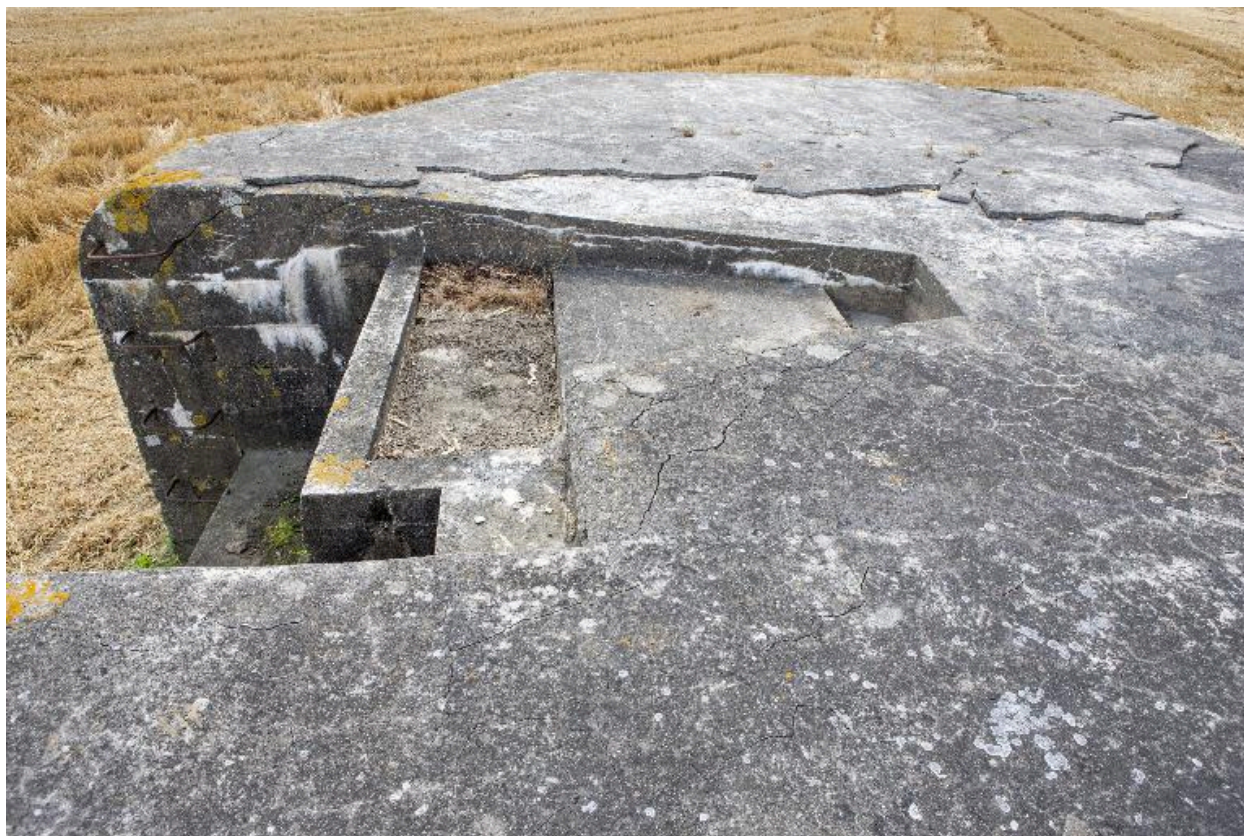
Blocage de l'affût de l'arme sur le toit, vers le sud-est
