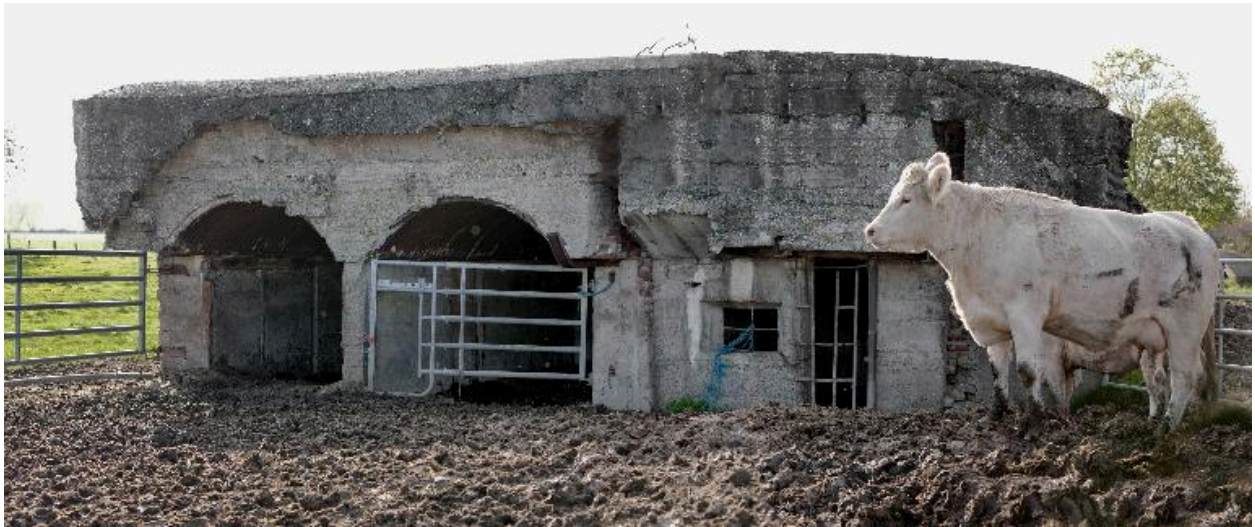
Vue générale vers le sud-ouest
