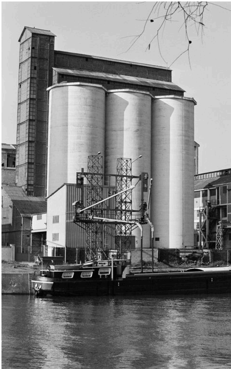
Réservoirs industriels : flanc est.
