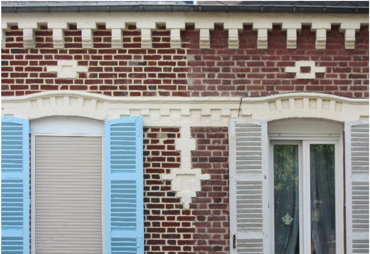
Détail du cordon et des éléments décoratifs de la façade sur rue.
