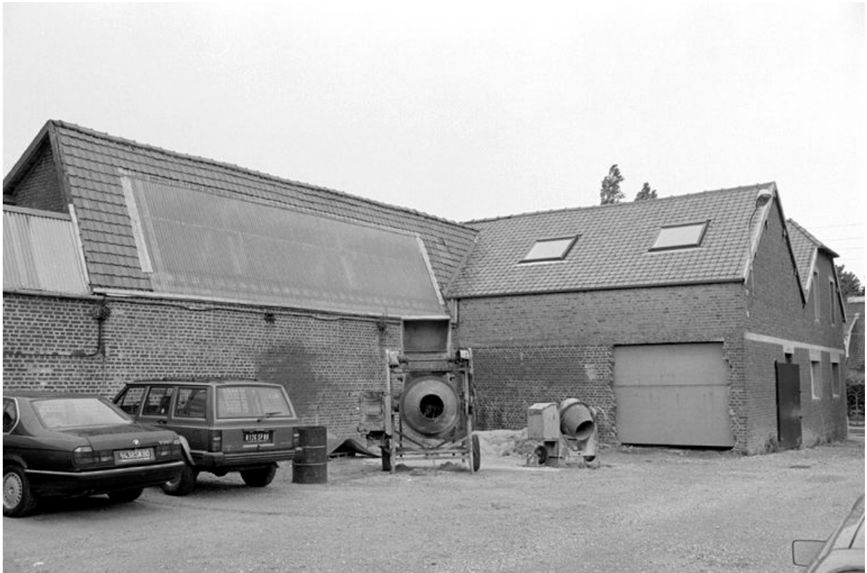
Atelier de fabrication, vue partielle en 1990, flanc est.
