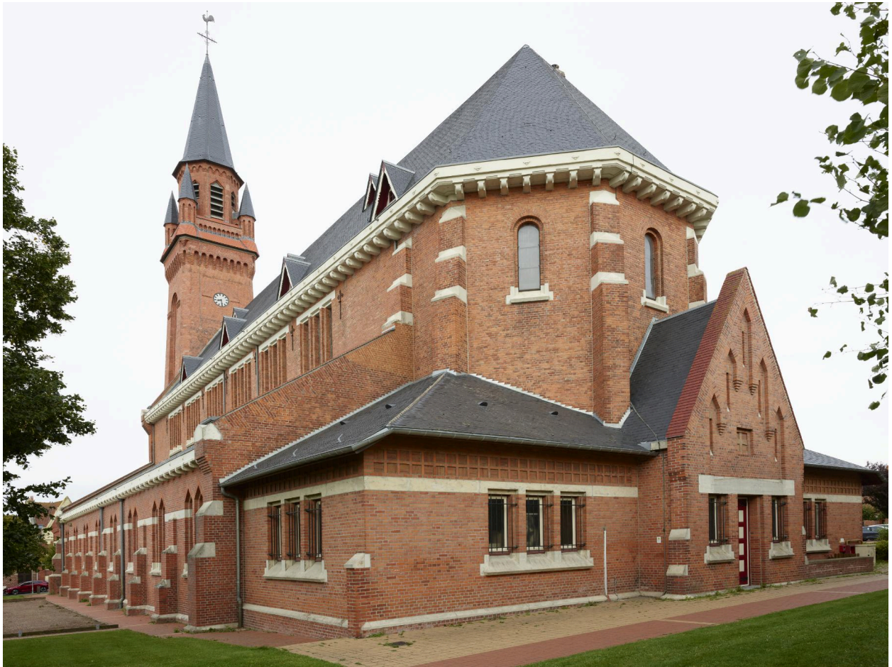
Vue générale de la partie sud prise depuis le chevet.
