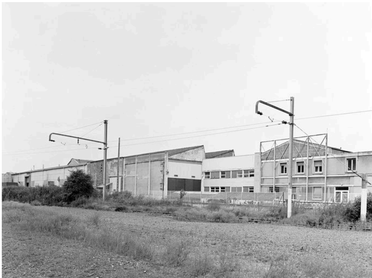
Vue générale de l'usine, flanc sud.
