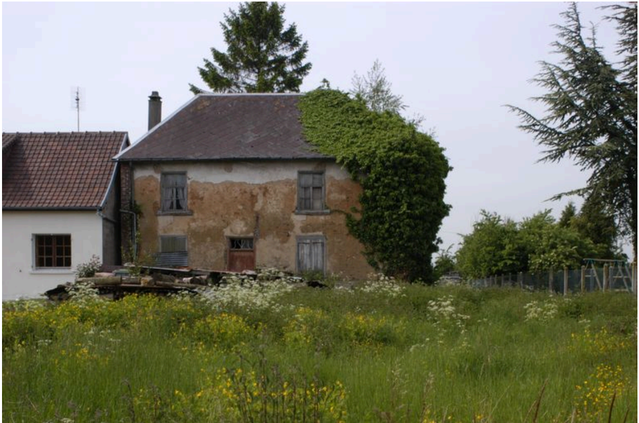
Vue de la façade nord.
