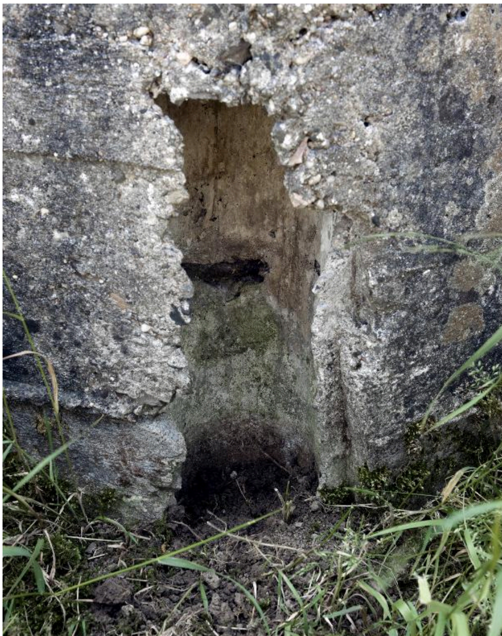
Elévation nord : empreinte de piquet de coffrage
