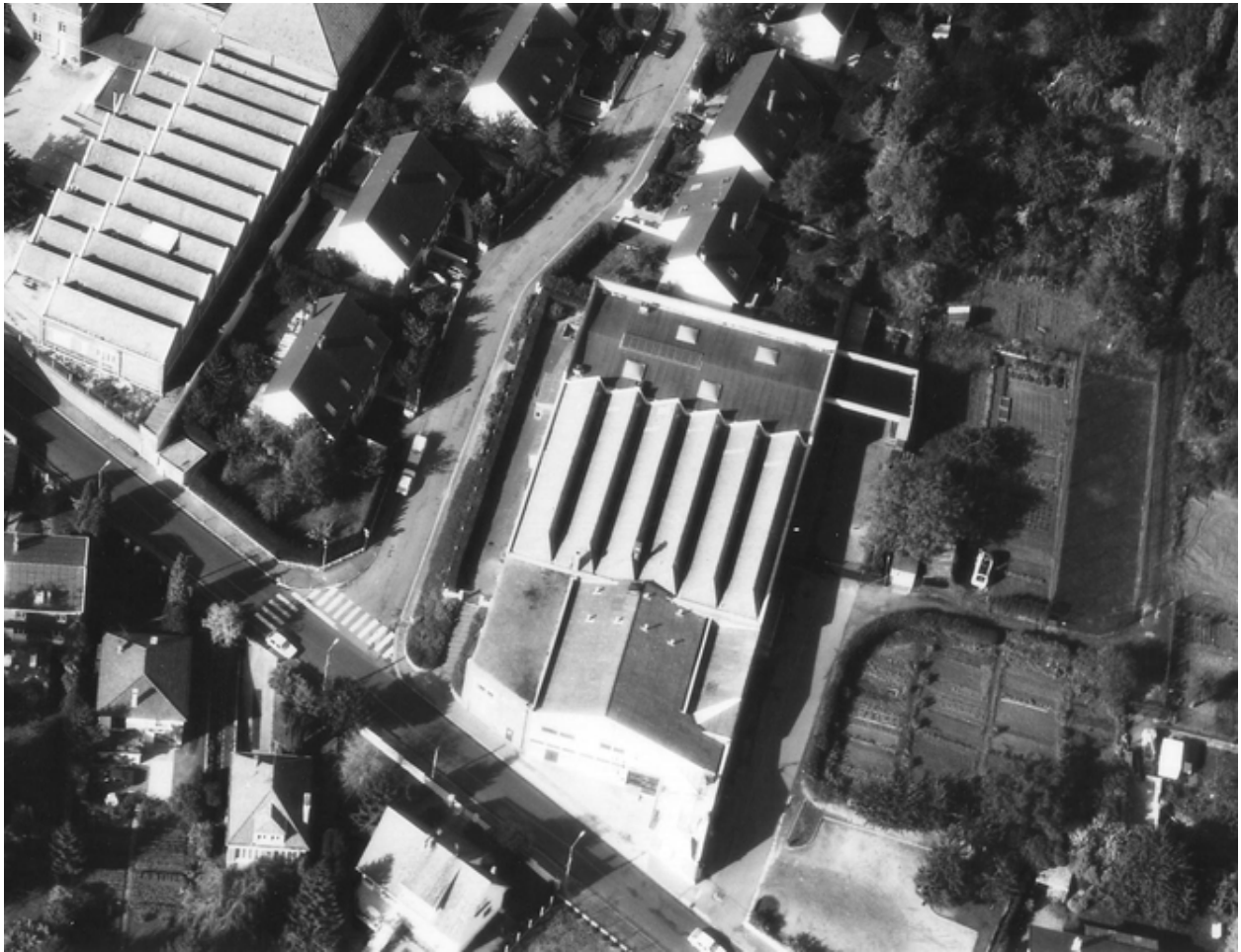
Vue aérienne de l'usine (en haut, à gauche, l'ancien tissage Sébastien) en 1989.
