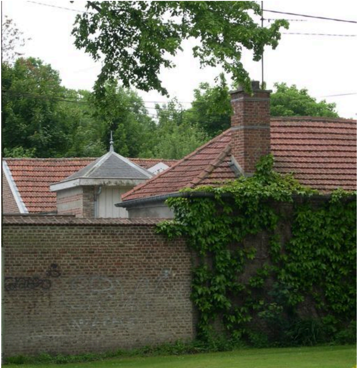
Détail sur le pavillon, situé dans la cour de la ferme.
