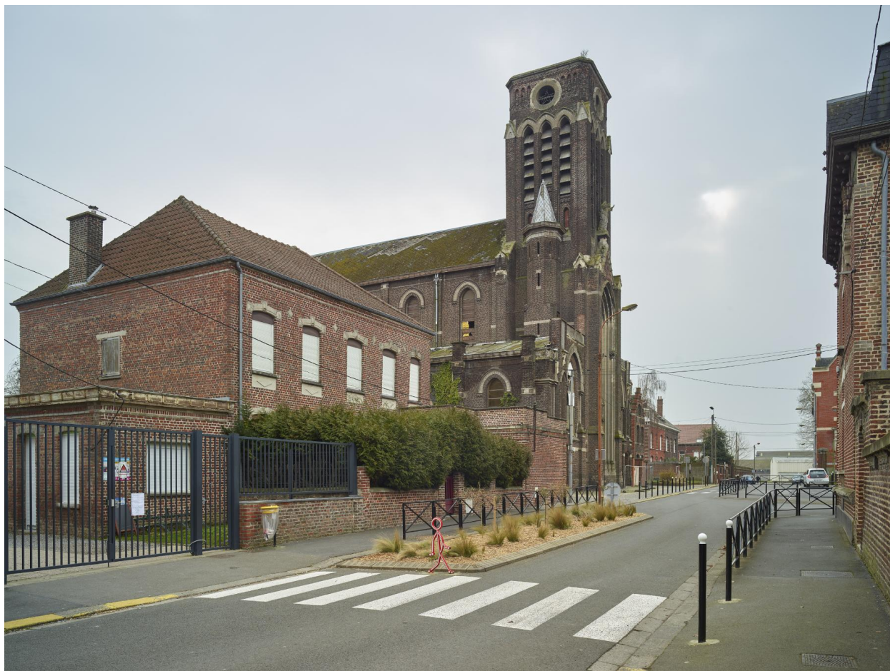
Vue générale de l'église vers l'est.
