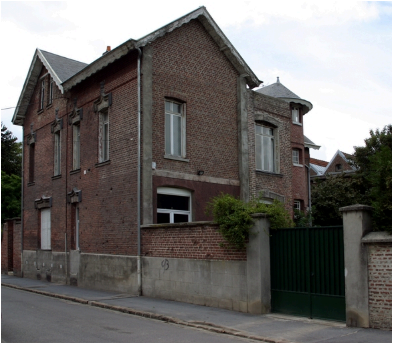
Façade postérieure du logement patronal.
