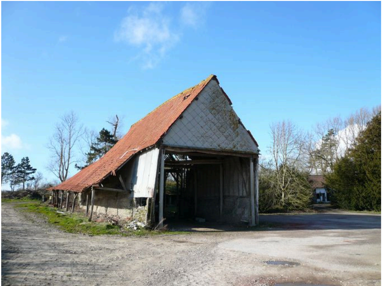
Vue de la grange depuis le sud-ouest.
