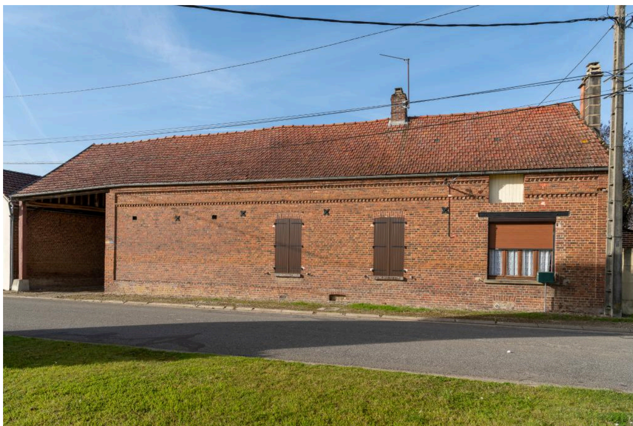
Logis en brique avec entrée charretière, n°59 rue Principale, vue depuis l'est.
