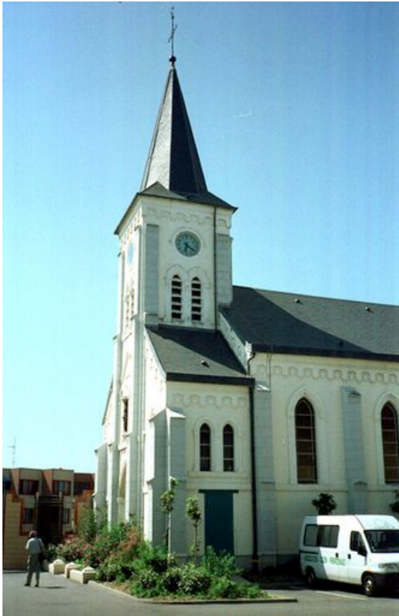
Vue d'ensemble de trois-quarts de la façade avec la tour de clocher, 1888 (pose de la première pierre), 1889.
