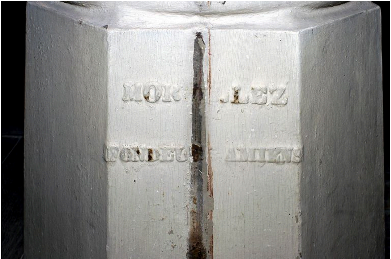
Vue de détail : pilier en fonte.
