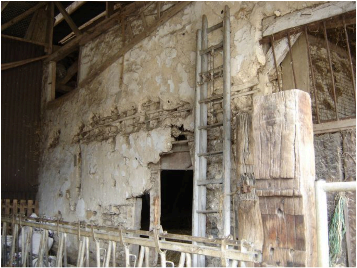
Vue du mur gouttereau sur cour.
