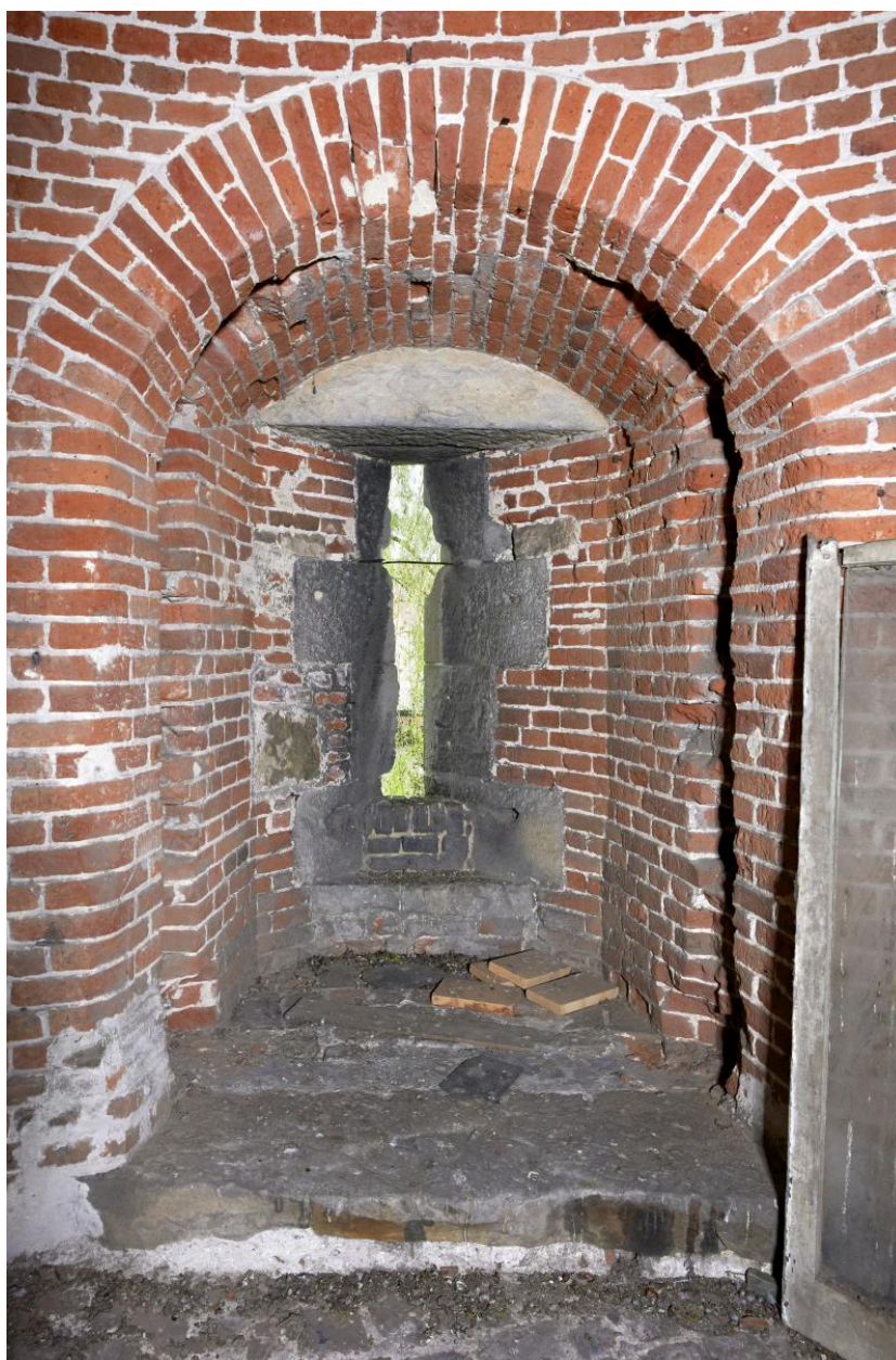
Niveau principal (R+1). Niche de tir nord-ouest.
