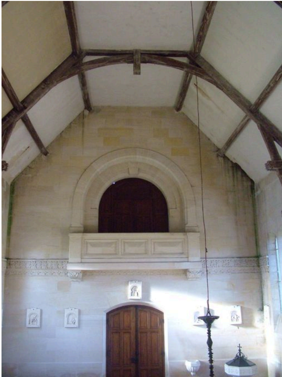
Vue intérieure du mur ouest.
