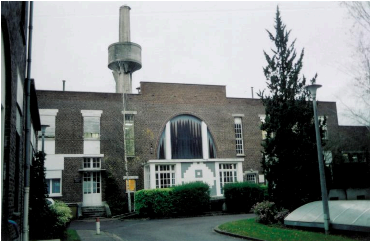
Bâtiment des services généraux.
