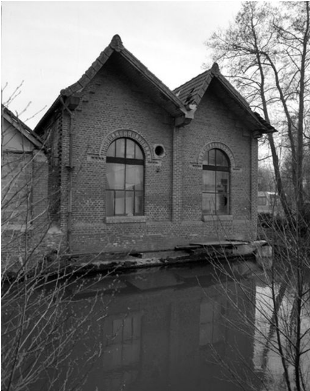
Vue partielle de l'atelier de fabrication.
