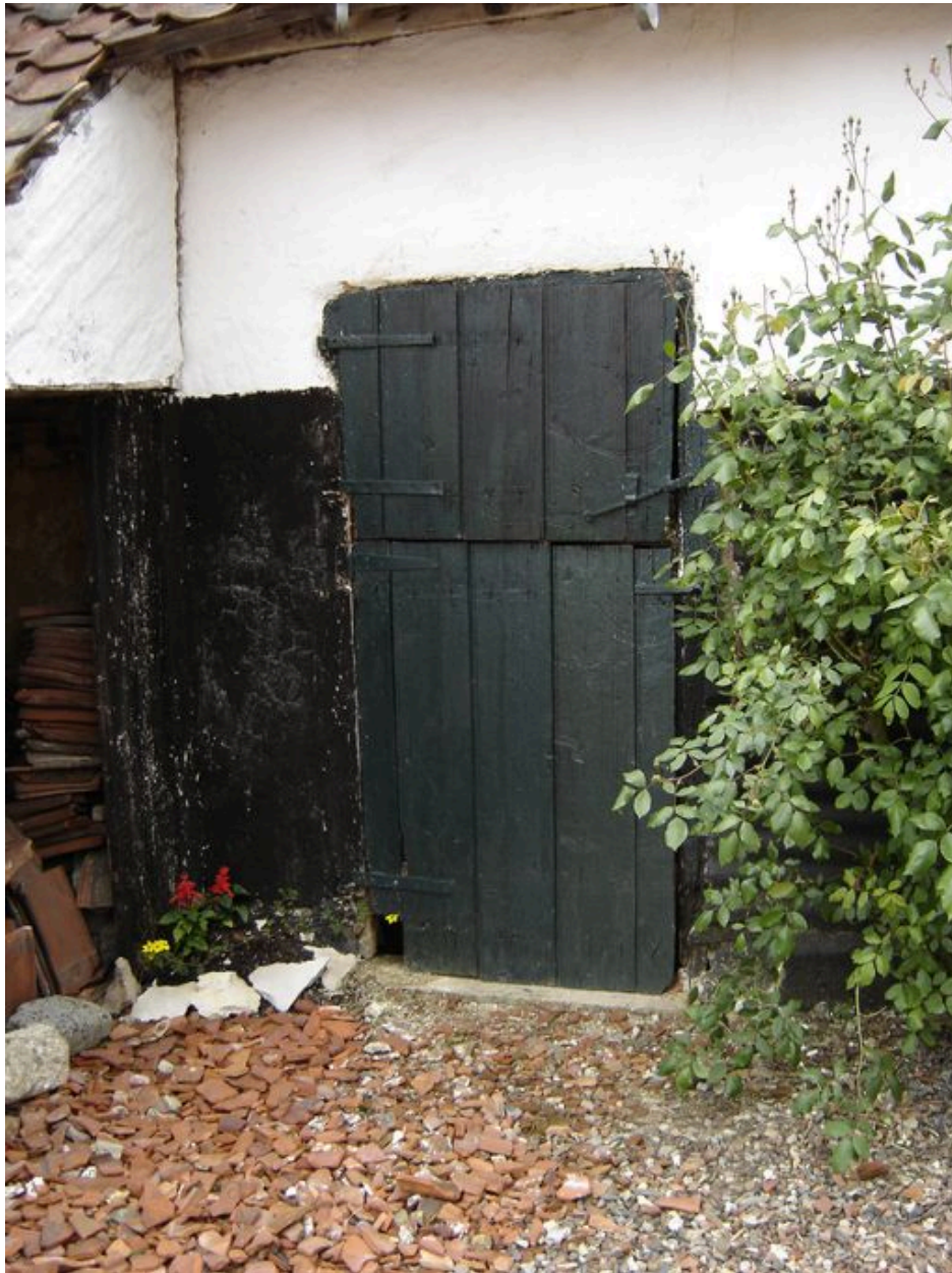
Vue détaillée d'une autre porte.
