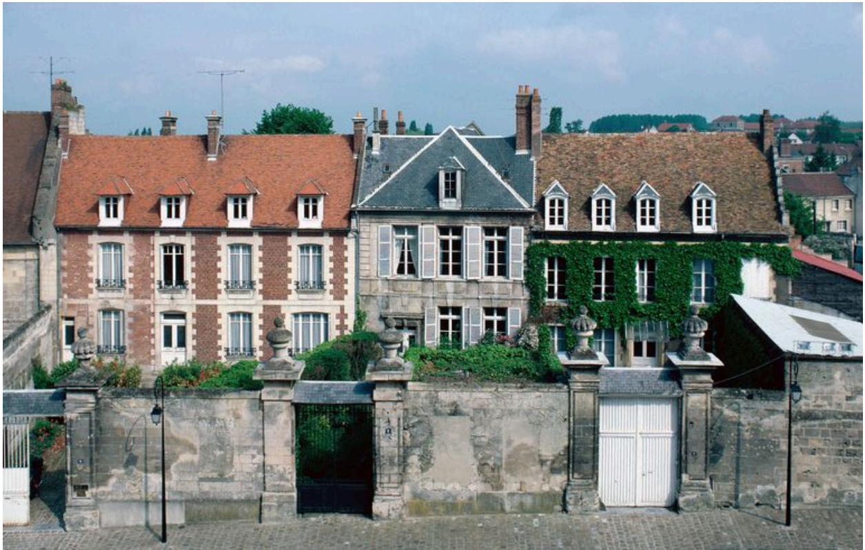
Vue des maisons de chanoines, 4, 5 et 6 place du Parvis.
