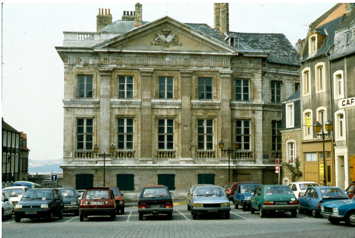
Façade sur la place Godefroy de Bouillon.
