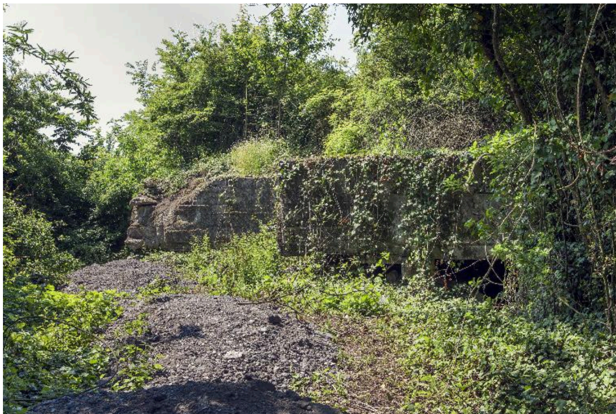
Vue générale, vers le nord-ouest
