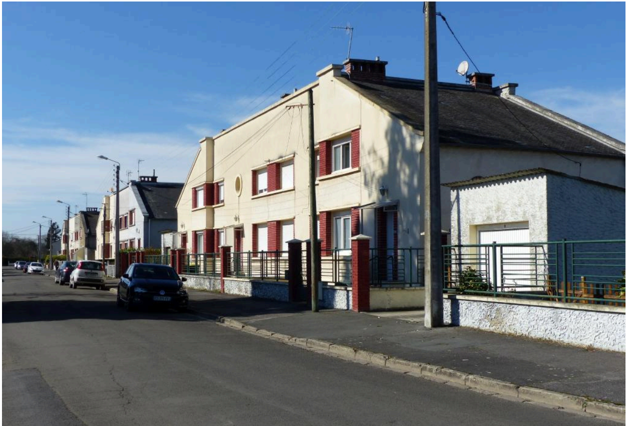
Groupes de logements, rive nord de la rue Hélène-Boucher.
