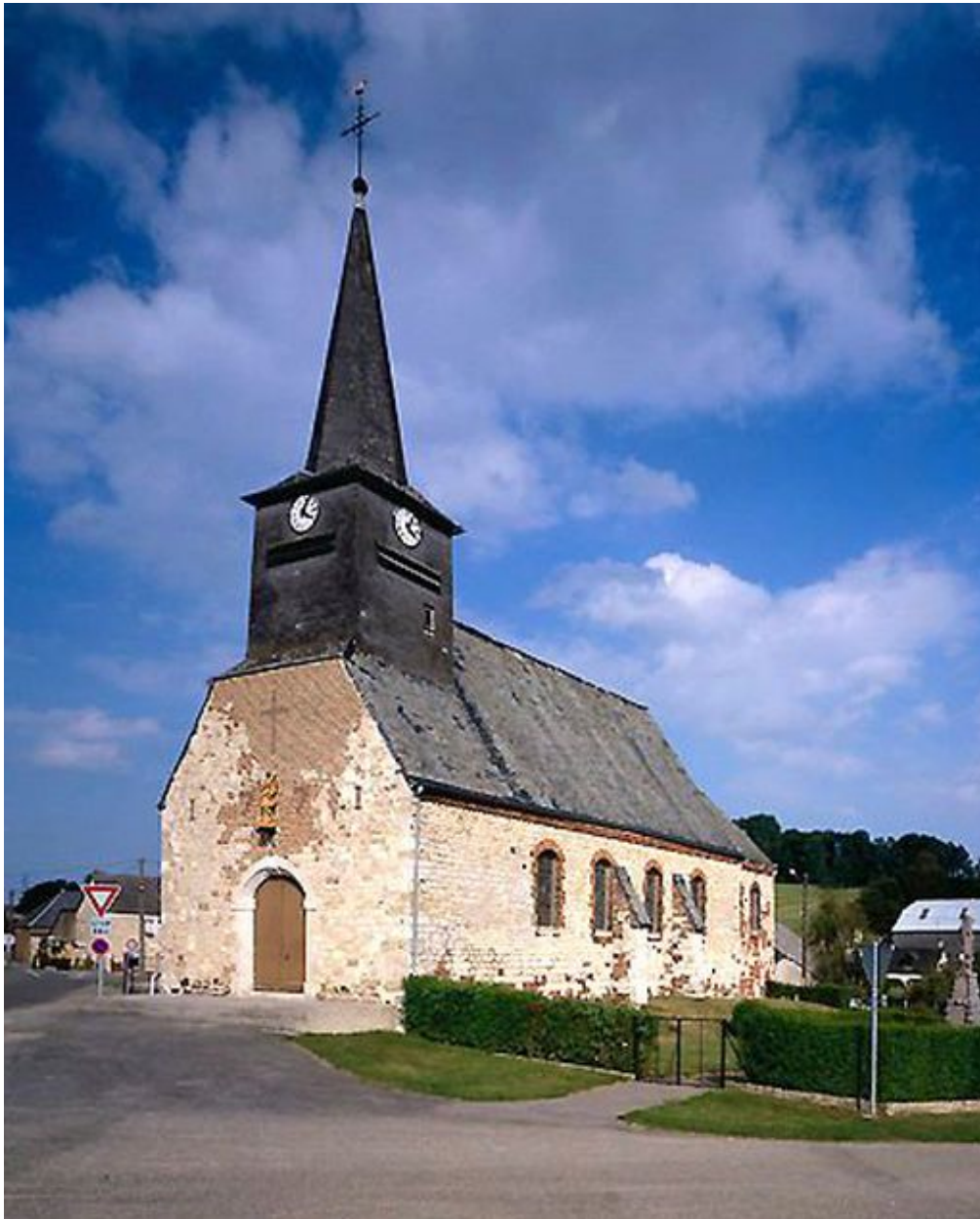
Façade occidentale, vue depuis le sud-est.
