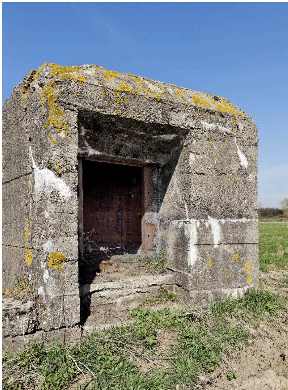
Entrée de l'observatoire casematé
