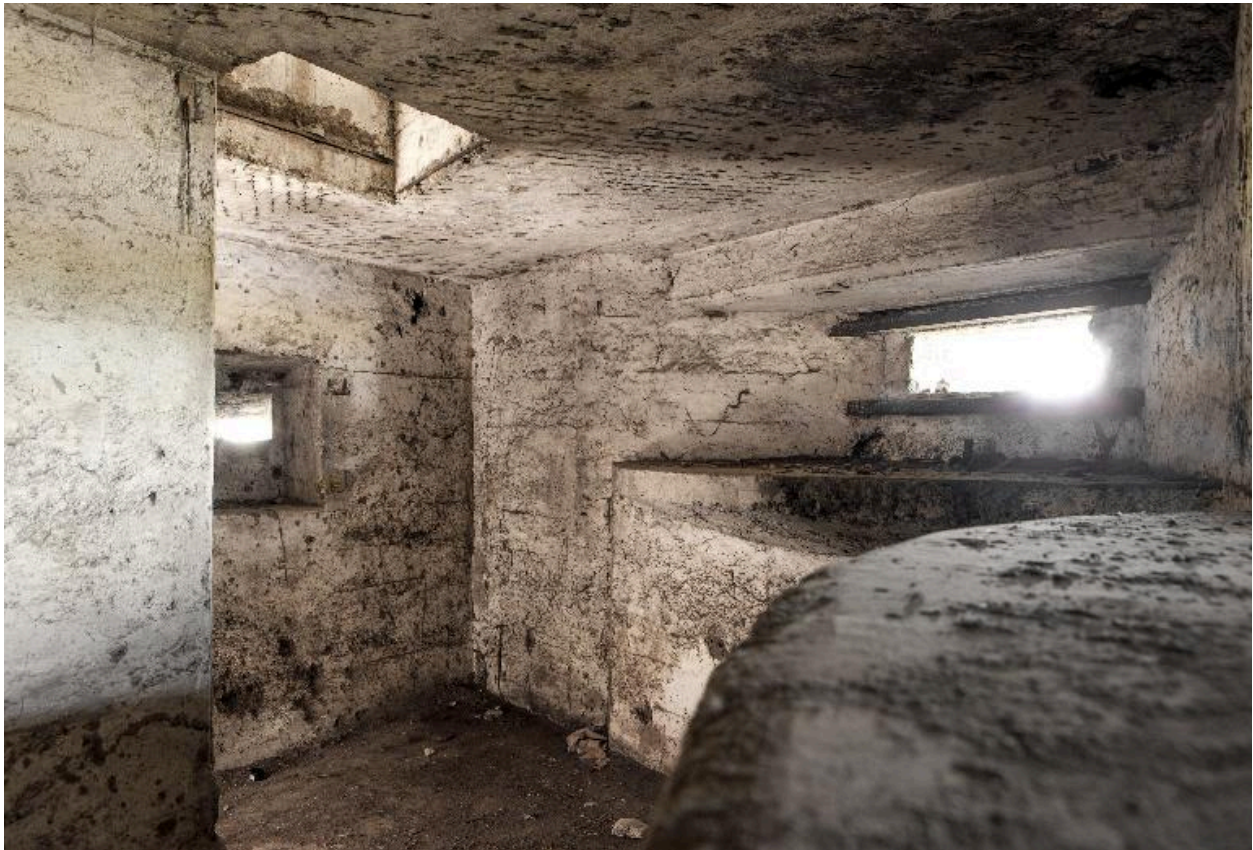
Rez-de-chaussée, vue générale vers le sud au grand-angle
