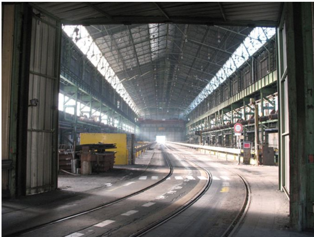
Passage couvert entre les ateliers du recuit et les lignes de galvanisation.
