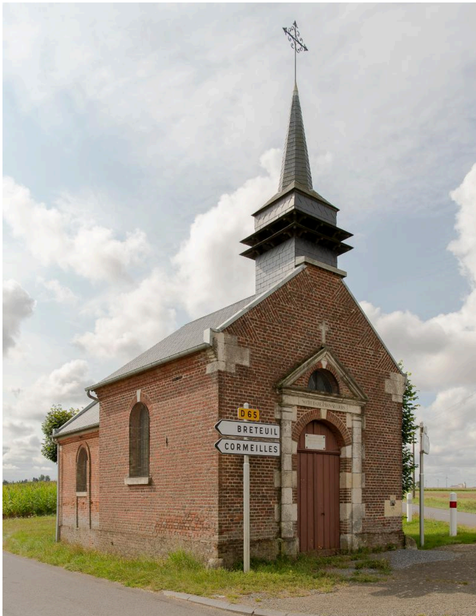
Vue depuis le nord-est.
