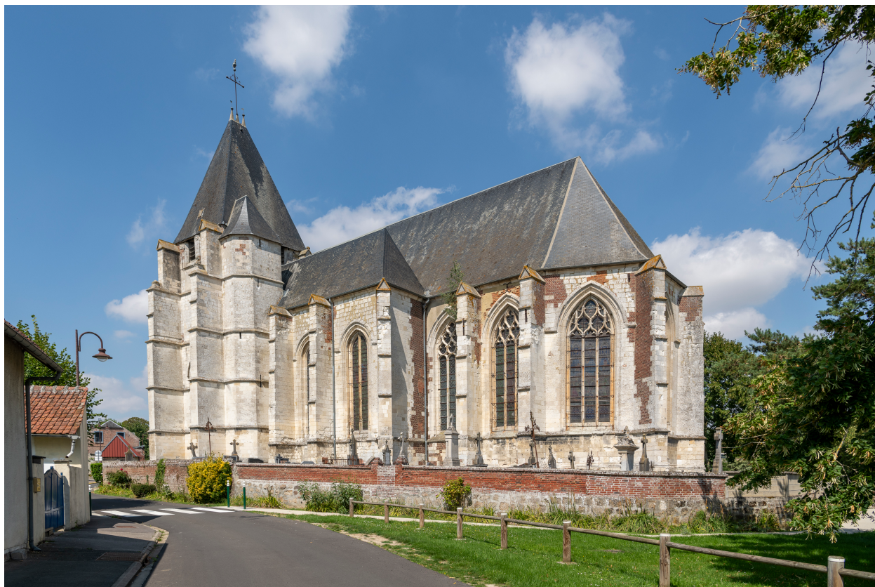
Église, vue prise depuis le sud-est.
