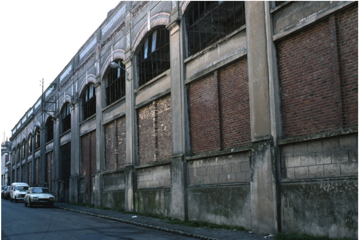
Façade des ateliers, rue Vauban, en 1983 (BM Saint-Quentin).
