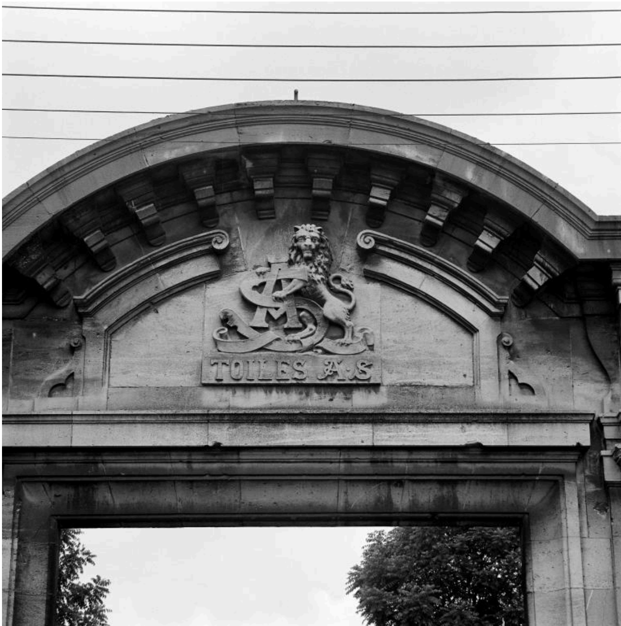
Portail d'entrée, rue Jules-Lebleu. Détail du tympan aux armes de l'entreprise.
