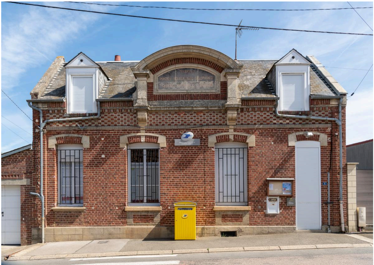
Poste de Thieux, vue depuis le sud.
