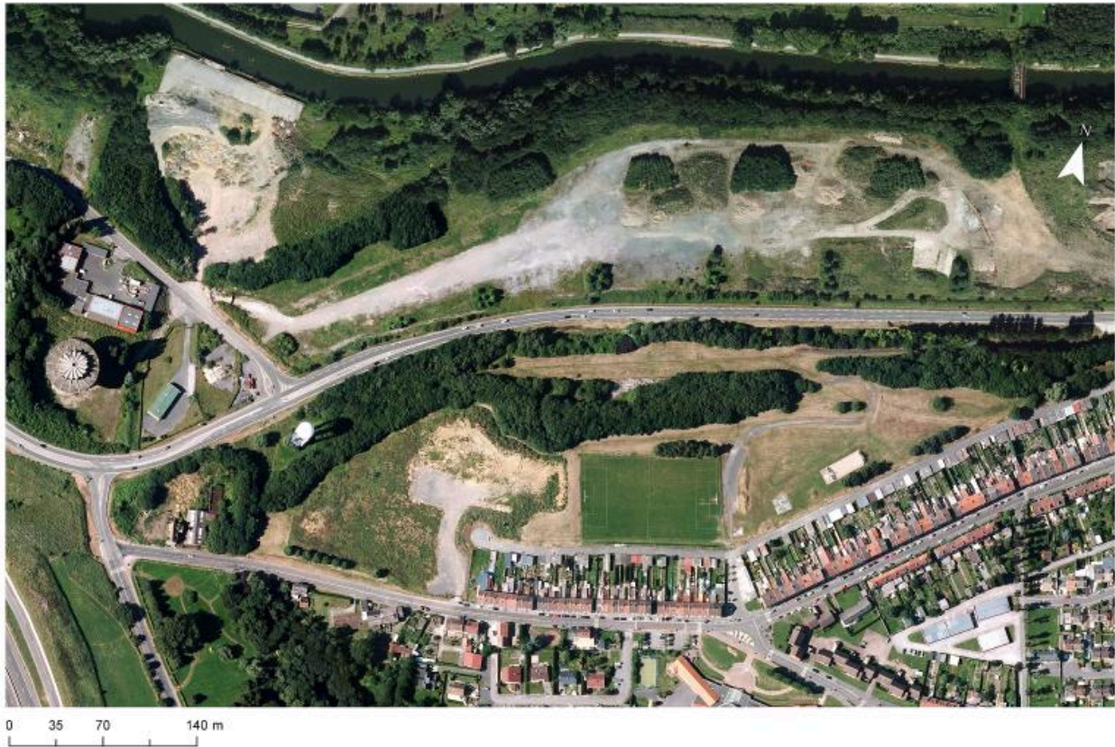
Vue aérienne de l'ancien site d'Usinor en 2015. À gauche, le dispatching (répartiteur). (Source IGN. Photothèque Nationale. 2015).
