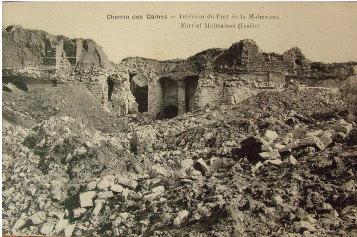
Intérieur du fort en ruines.
