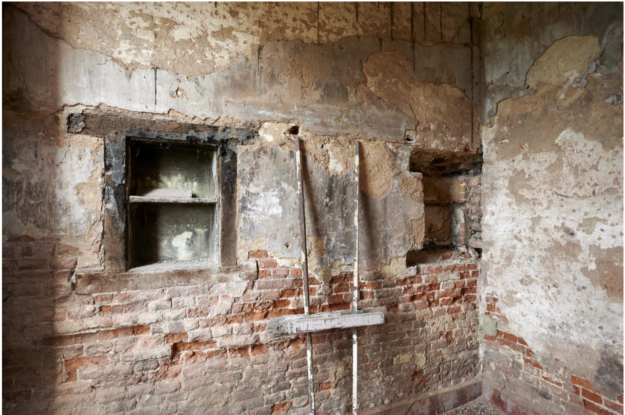
Rez-de-chaussée. Réduit du logis du XVI e siècle.
