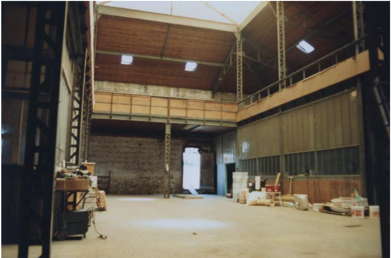
Ancien atelier de fabrication, en 1990.
