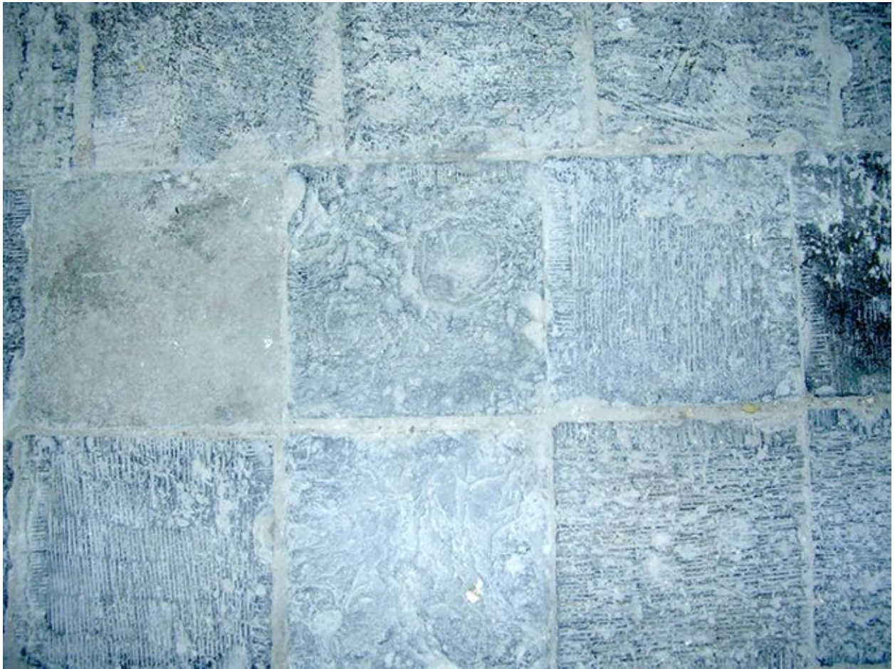
Dalles de la chapelle des Forges réemployées pour le sol de l'église.
