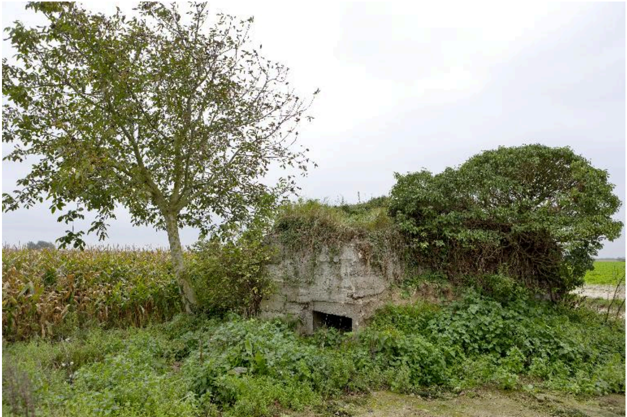
Vue de trois-quarts vers le sud-ouest. Une des deux entrées
