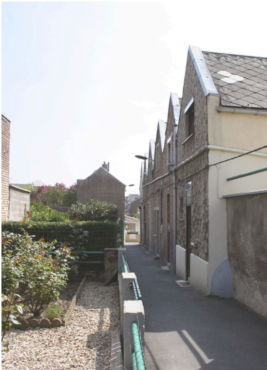
Entrée de la cour Datra (premier groupe de six logements).
