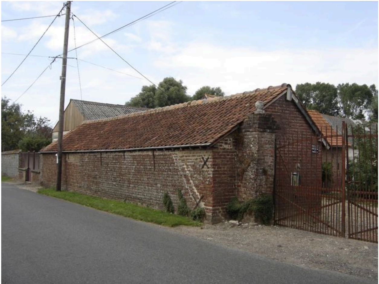
Vue des étables sur rue.
