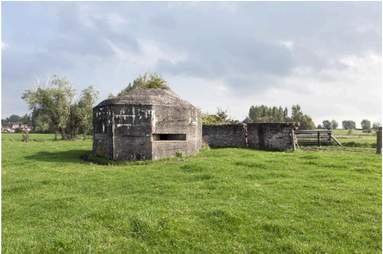
Vue générale vers le sud-est
