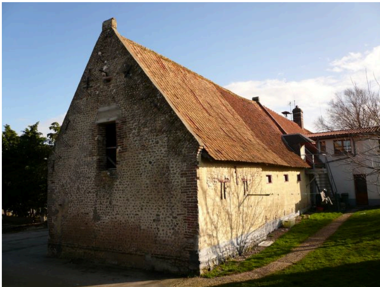
Vue postérieure de l'écurie.
