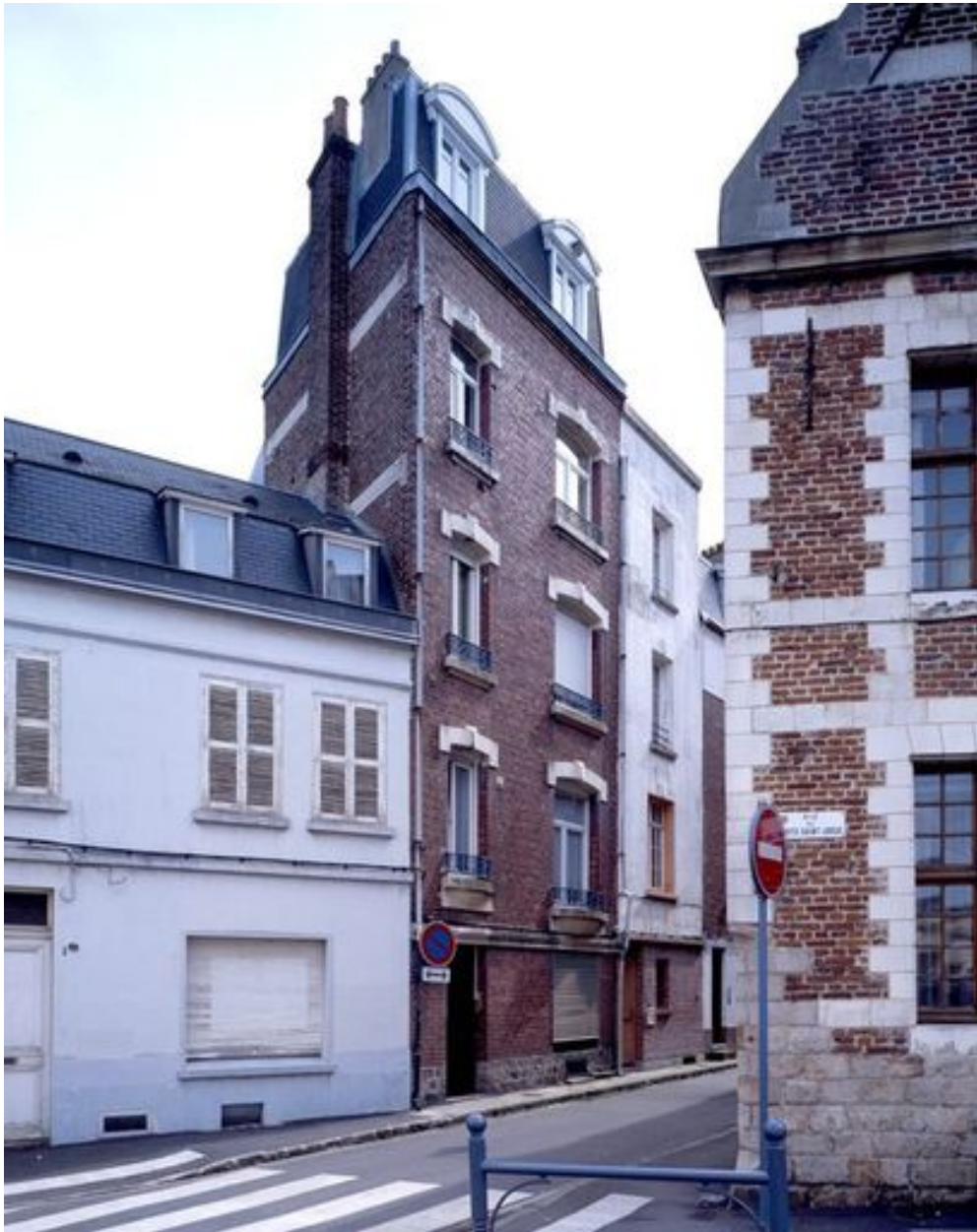
Vue générale, façade rue du Fer-à-Cheval.
